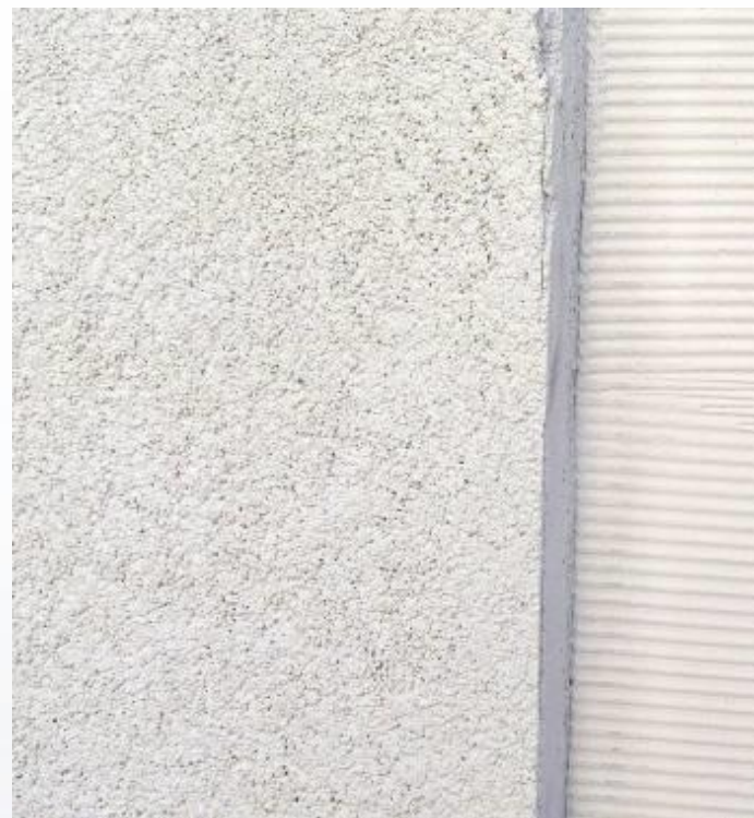
Теплоизоляционная штукатурка с промежуточным слоем
