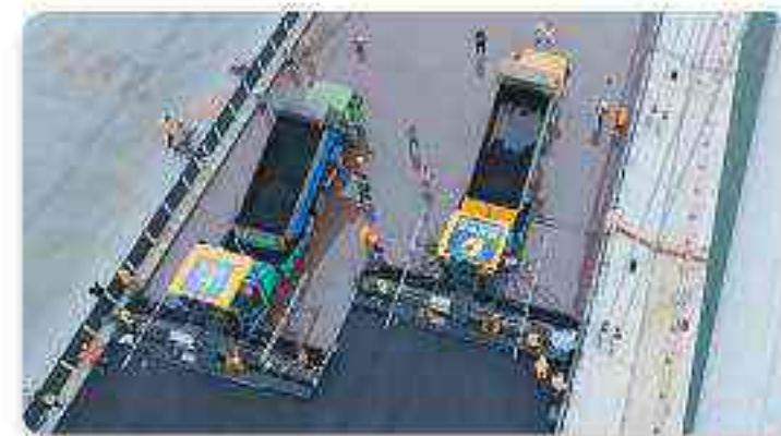
Эпоксидное асфальтовое покрытие на стальном мосту
