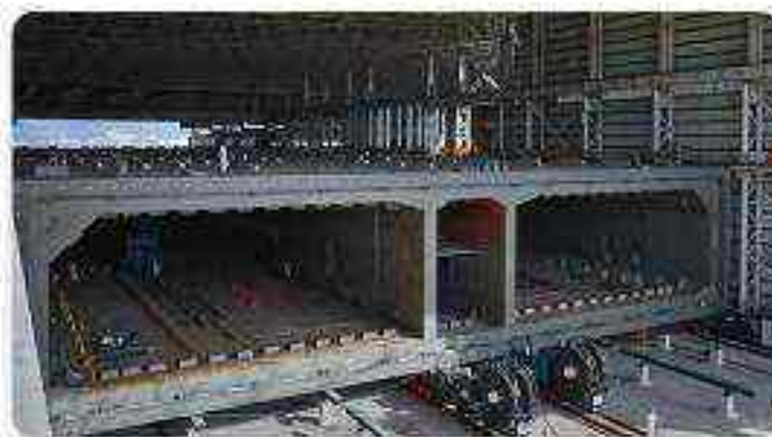
Подводные тоннели из погружных секций
