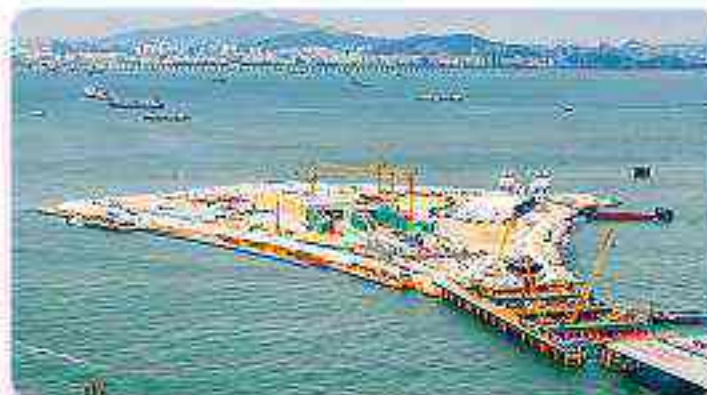
Подводное строительство искусственных островов
